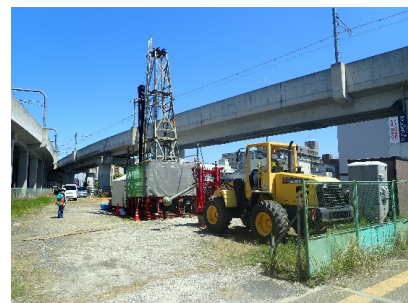
ボーリング孔によるVSP調査
