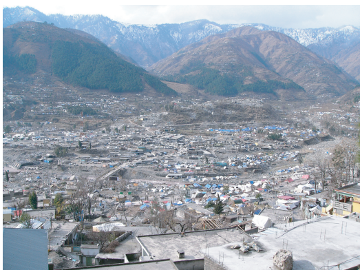
写真3 壊滅的な被害を受けたBalakotの町。南西方向を望む。地表地震断層は写真中央の細長い丘陵の南西縁に沿って出現した。
