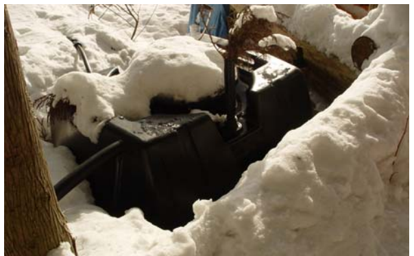
写真-4 貯水タンクからの漏水状況
