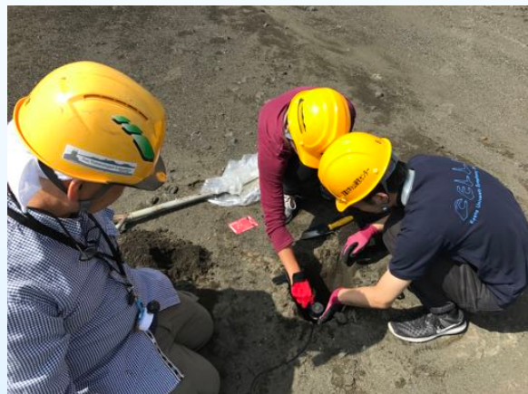
地震計を設置
